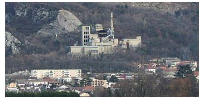
L'ancienne usine Vicat vue depuis la plaine
