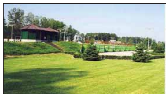
Déchèterie pilote du Pays Voironnais, 1993.
