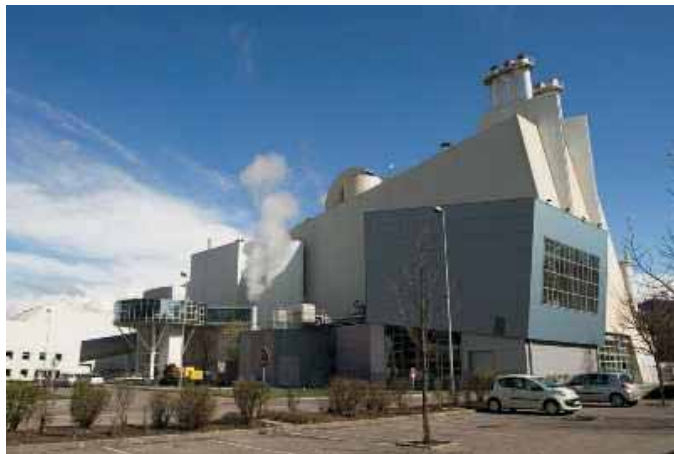
Usine d'incinération avec valorisation énergétique Athanor, La Tronche (38)
