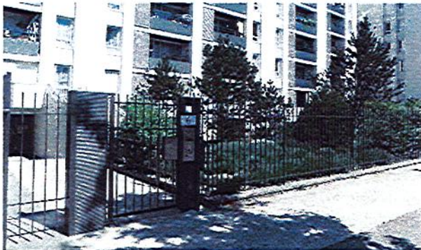
Exemple de serrurerie en limite d'espace collectif
