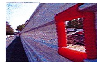
Limitation des poussières : goulotte + bâche Et protection acoustique
