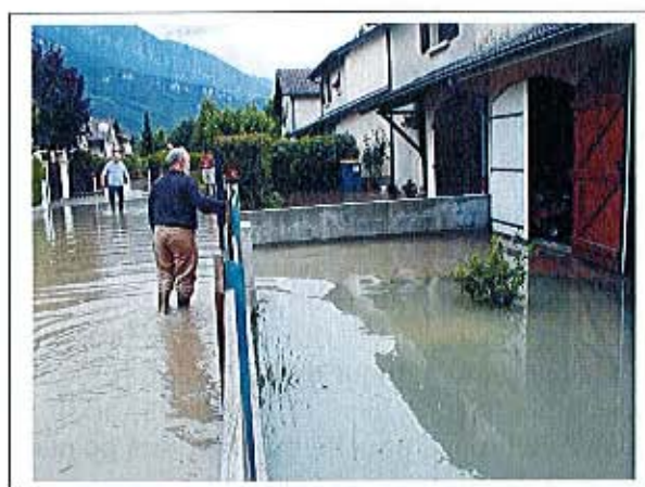
Débordement du canal de la Volouise et inondation du lotissement du canal en juin 2002 Source Mairie
