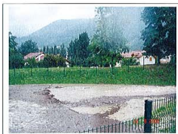
Plage de sédimentation du Malsouche lors de la crue du 22 août 2005. Source : mairie
